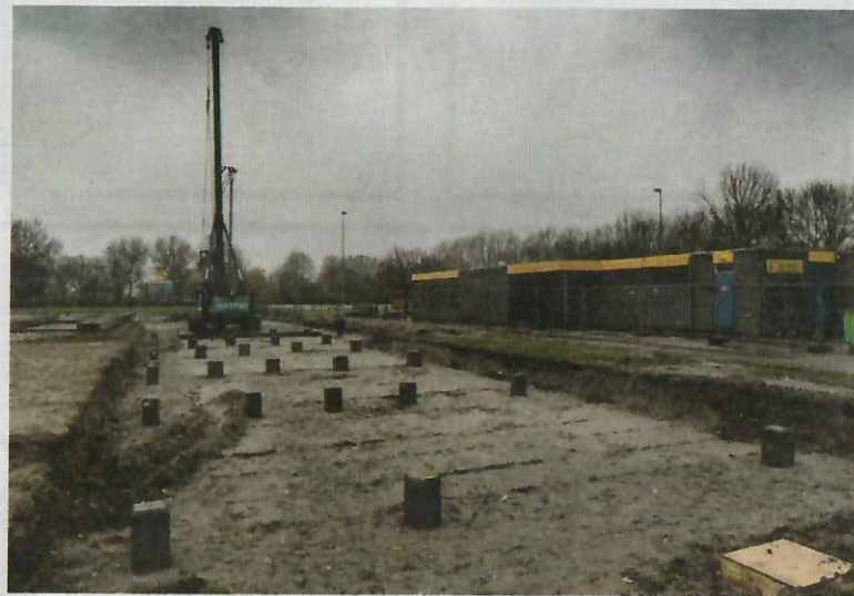
De komende maanden wordt in Sportpark Reijerpark een nieuwe sporthal gebouwd.
